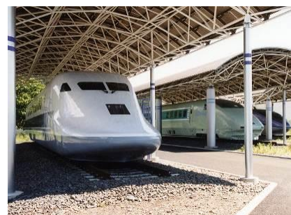
新幹線高速試験車両保存場
